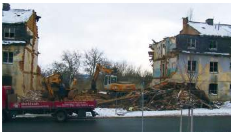
Abriss der „Russenhäuser“ Neundorfer Str. 195-199 im Jahre 2012
